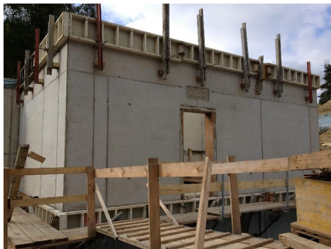
Das neue Reservoir auf der Allmend nimmt Gestalt an.
