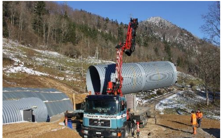
Einbau des Zwischenreservoirs bei der Wäscheten.
